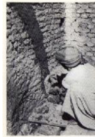
9. Une première brique est posée contre le mur.
