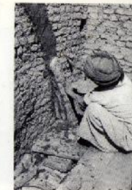
12. La troisième assise devient encore plus de la verticale.
