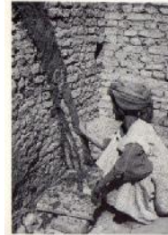
13. Le maçon applique de la bane.
