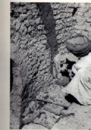
11. Une troisième brique termine la seconde assise.
