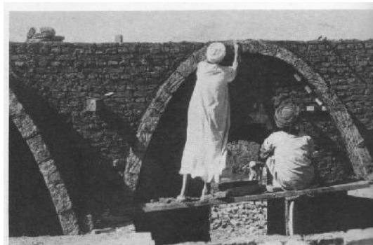
17. Les maçons remplissent les interstices de cales sèches.
