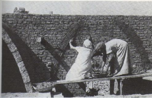
7. Les maçons forment la parabole avec de la boue.
