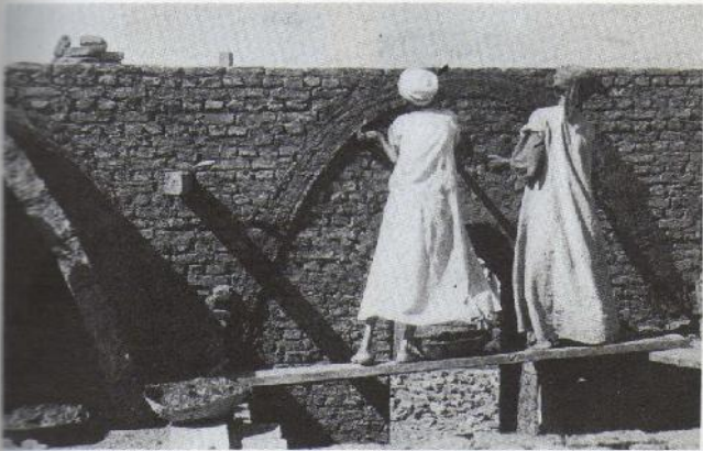
8. Ils précisent la parabole avec la doloire.
